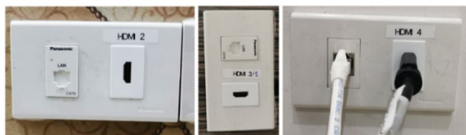
ภาพที่ 4.20 ตัวอย่างจุดเชื่อมต่อสาย HDMI ภายในห้องประชุมสำนักกิจการนักศึกษา
