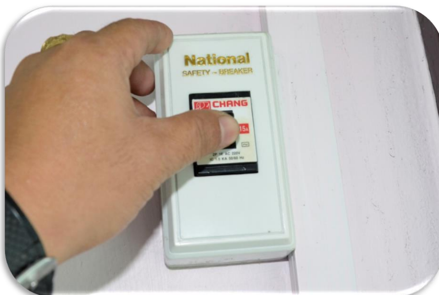
ภาพ 4.17 แสดงการโยก Breaker ในตำแหน่งเปิด( ON )
