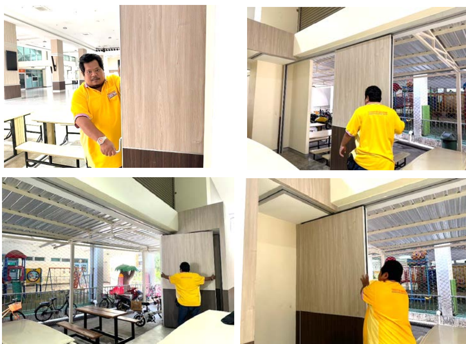
ภาพที่ 4.12 ปรับพื้นที่ห้องประชุมให้เป็นแบบปิด โดยใช้ฉากกั้น
